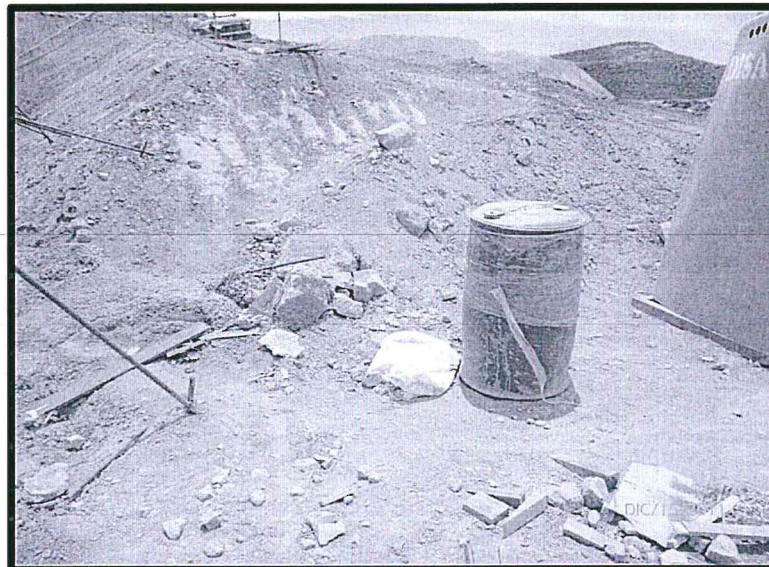
Fotografía N° 3: Inadecuada disposición de los residuos sólidos industriales peligrosos y no peligrosos en el área industrial en construcción, los residuos sólidos (recipientes vacíos de aditivos) se ubican fuera de los contenedores y sobre terreno natural.
