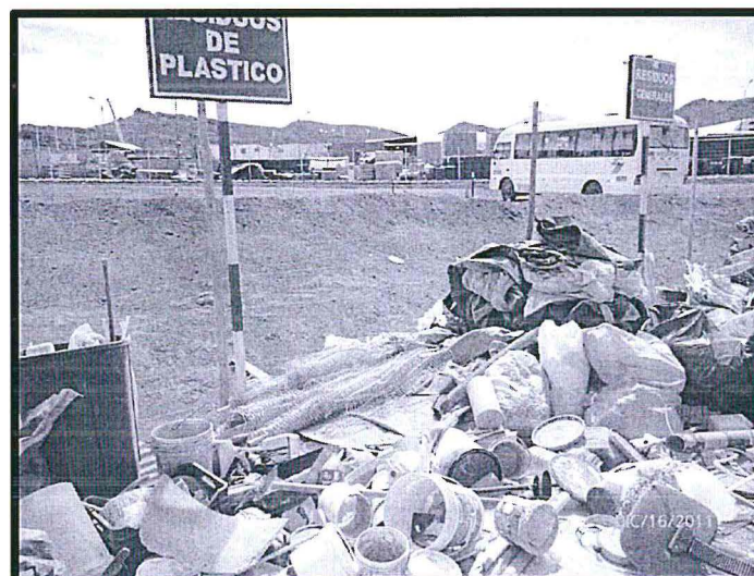
Fotografía N° 8: Almacenamiento de residuos industriales y peligrosos contaminados y no contaminados, no se realiza un adecuado manejo de los residuos al interior del depósito temporal.
