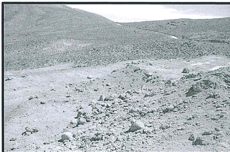
Fotografía N° 10: Bancos conformados en el depósito de Top Soil, dicho depósito no cuenta con estructuras hidráulicas construidas
