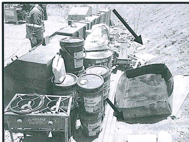
Fotografía N° 34: Residuos industriales peligrosos y no peligrosos (recipientes de aceites y lubricantes usados, maderas, sacos usados, restos de metal, etc.) en terreno natural en la planta de concreto de Cosapi, no se observa sistemas de impermeabilización y contingencia para evitar impactar el entorno de la zona.
