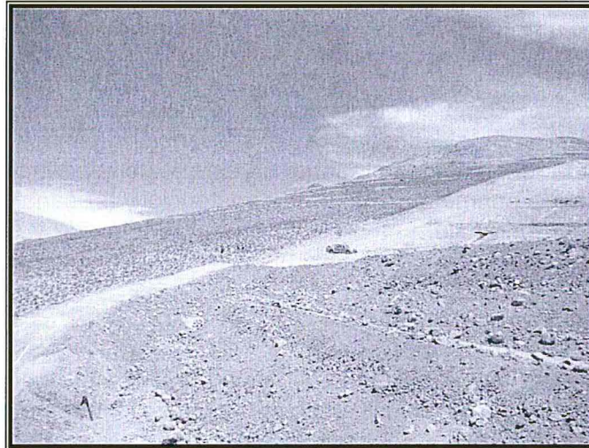
Fotografía N° 29: Base del depósito de desmontes de la unidad minera, no se observa la capa impermeabilizante en base a caliza de 3,000 mm. de espesor y no se observa estructuras hidráulicas para evacuación de aguas de escorrentía.
