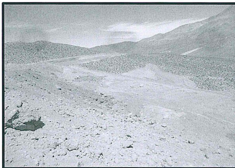
Fotografía N° 11: Bancos conformados en el depósito de Top Soil, dicho depósito no cuenta con estructuras hidráulicas construidas
