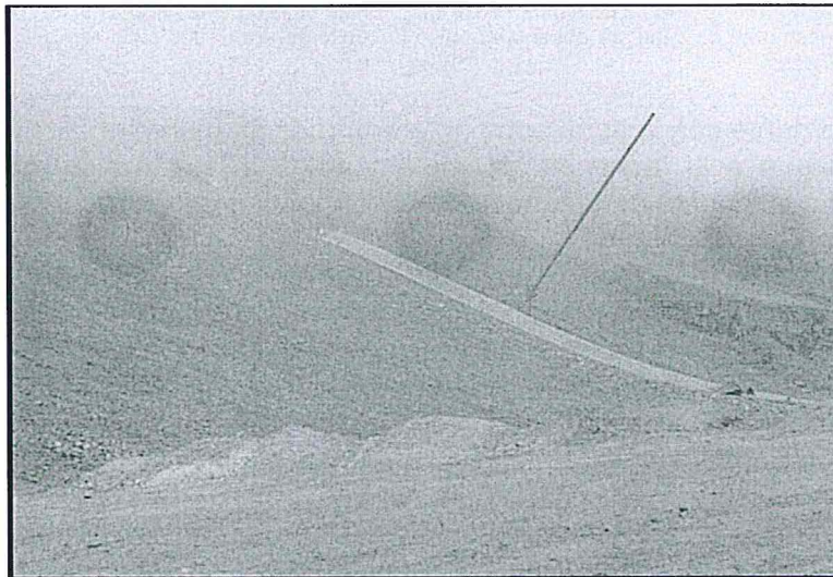
Fotografía N° 8.- Vista del canal lateral de captación izquierdo de escorrentía en el depósito de desmonte de mina.
