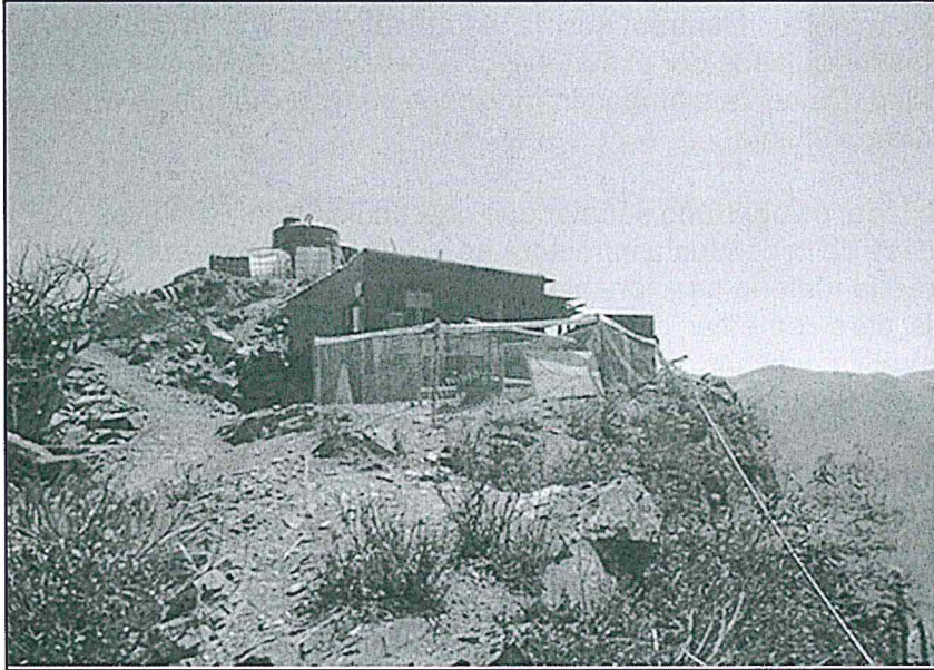
Fotografía N° 7 del Informe de Supervisión.- Almacén general de perforación y tanques de agua.
