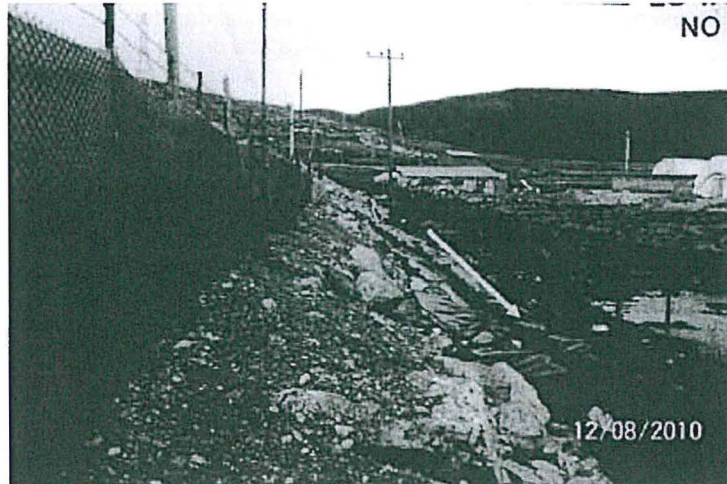
Fotografía N° 2.57: Aproximadamente a 300 metros antes de llegar a la cancha de mineral existe un canal de esorrentía colindante con la comunidad de Huaraucaca.
