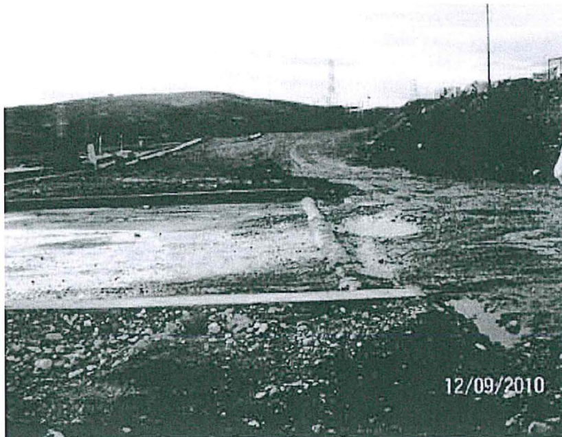
Fotografía N° 2.72: Se aprecia parcialmente la losa de concreto construida en la plataforma de la garza y se nota que no hay anegamiento en el terreno del lugar.
