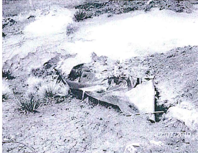
Fotografía N° 2.42: En el punto de descarga considerado para evacuar las aguas provenientes del taller de mantenimiento de la Contrata Consorcio Pasco, las aguas discurren por debajo de la geomembrana.
