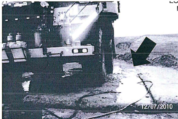
Fotografía N° 2.43: En el área de lavado de vehículos de la contrata Consorcio Pasco se nota que existe una plataforma de concreto incompleta del mismo modo existe solo un tramo del canal perimetral donde se distingue la rejilla.
