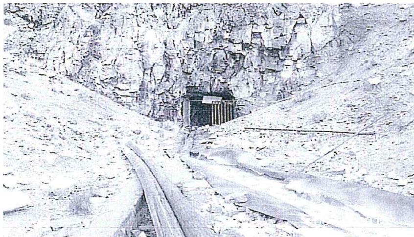
Fotografía N° 2.45: Vista panorámica del sistema de conducción de las aguas de la bocamina Beatricita a las pozas de tratamiento y sedimentación.
