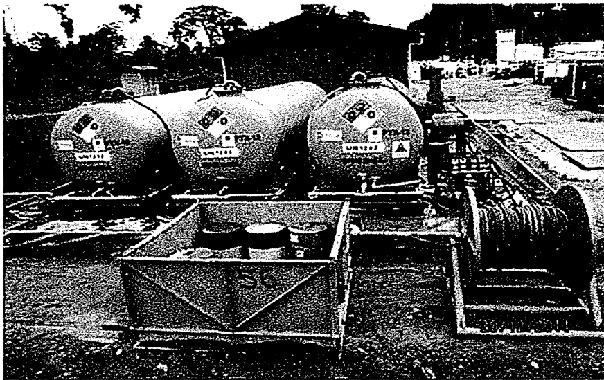
Fotografía N° 12: Inadecuado almacenamiento de los combustib
