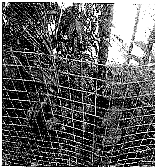
Fotografía N° 17: Se limpió el área y se implementó un cerco de malla para evitar la caída de residuos a la ribera del río.
