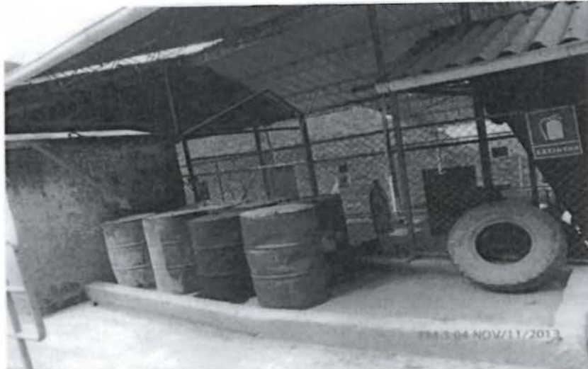
Fotografía N° 92 del Informe de Supervisión.- Durante la supervisión, se observó cilindros con aceite usado (residuo peligroso) que no cuentan con un cerco perimétrico ni letrero de identificación, los cuales se encuentran dispuestos cerca a los tanques inclinados de almacenamiento temporal de aceites usados.
