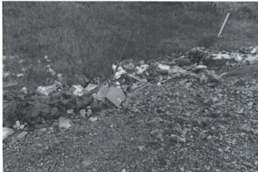
Fotografía N° 114 del Informe de Supervisión.- Durante la supervisión, se observó en el interior del relleno sanitario residuos sólidos expuestos a la intemperie, sin cobertura de préstamo.
