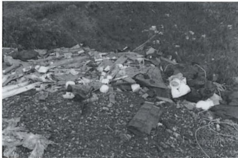
Fotografía N° 113 del Informe de Supervisión.- Durante la supervisión, se observó en el interior del relleno sanitario residuos sólidos expuestos a la intemperie, sin cobertura de préstamo.
