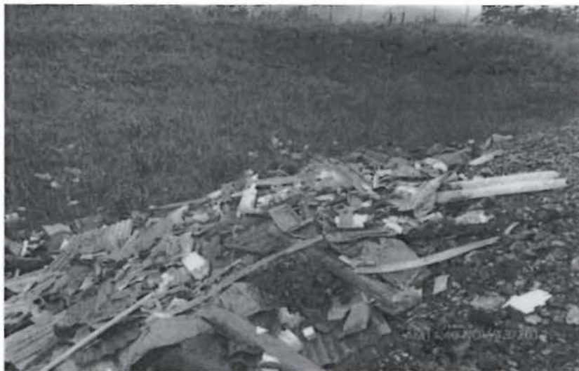
Fotografía N° 112 del Informe de Supervisión.- Durante la supervisión, se observó en el interior del relleno sanitario residuos sólidos expuestos a la intemperie, sin cobertura de préstamo.
