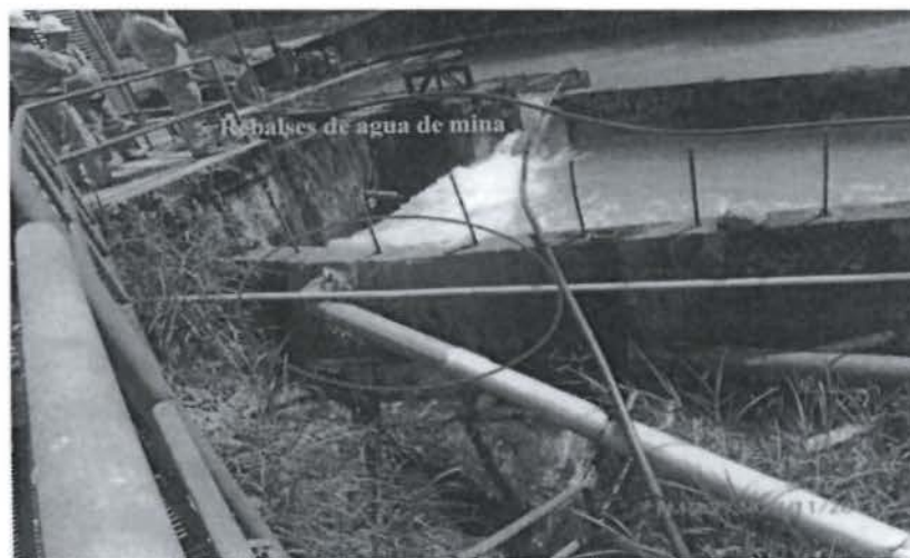
Fotografía N° 89 del Informe de Supervisión.- Durante la supervisión, se observó que el Sedimentador N° 1, donde se tratan las aguas de mina que salen mediante un canal por la bocamina Nivel 4755, presenta rebalses de dichas aguas hacia la parte baja donde existe flora de la zona que es impactada por sólidos en suspensión.
