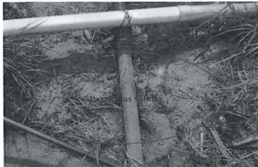
Fotografía N° 91 del Informe de supervisión.- Durante la Supervisión, se observó en la parte baja del Sedimentador N° 1, la presencia de partículas sólidas sobre suelo orgánico donde se aprecia que por dicha zona la flora existente ha sido impactada.
