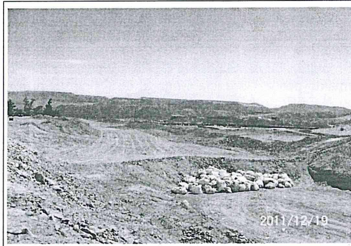
Foto N° 32: Levantamiento de la Recomendación N° 10-2009: La disposición de residuos sólidos en la Trinchera Sanitaria, colindante a la Plataforma de Almacenamiento Temporal de Residuos, carece de sistemas de impermeabilización, cerco perimétrico e identificación.
