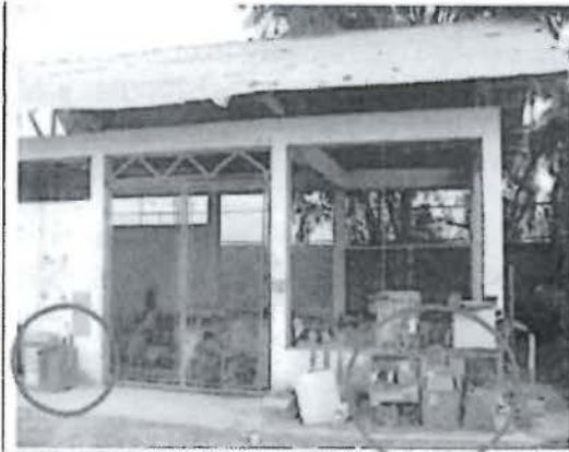
Vista 1. Ex Casa de máquinas convertida en Almacén central de residuos sólidos peligrosos.
