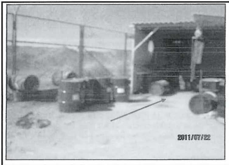
Fotografía N° 02: En el área de almacenamiento de lubricantes de la Bateria, se evidenció que los cilindros estuvieron ubicados fuera de la caseta de protección, asimismo, no cuentan con un sistema de contención secundario (solo tenía losa de concreto sin dique de contención o canaletas de drenaje).
