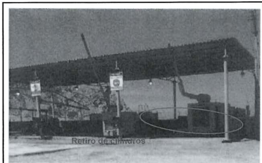
Fotografía N° 02: Se evidencia retiro de cilindros de área de bombeo de Batería Providencia 1.
