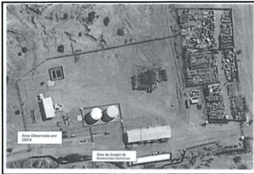
Fotografía N° 01: Se aprecia que el área observada por el OEFA es diferente al área de acopio de sustancias químicas.
