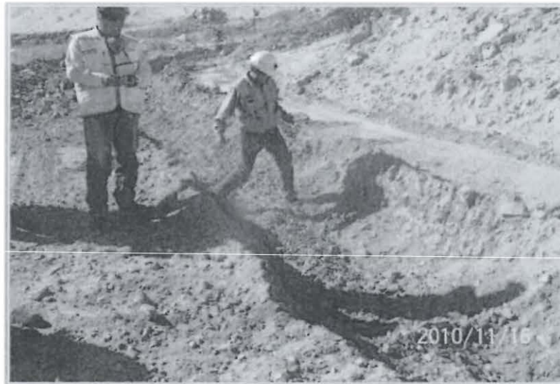
Fotografía N° 105: Depósito de desmonte Cuprita. Avance de la construcción del canal de derivación de aguas de escorrentía. Recomendación N° 18.
