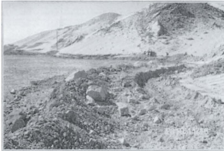
Fotografía N° 106: Depósito de desmontes Cuprita. Avance de la construcción del canal de derivación de aguas de escorrentía. Recomendación N° 18.
