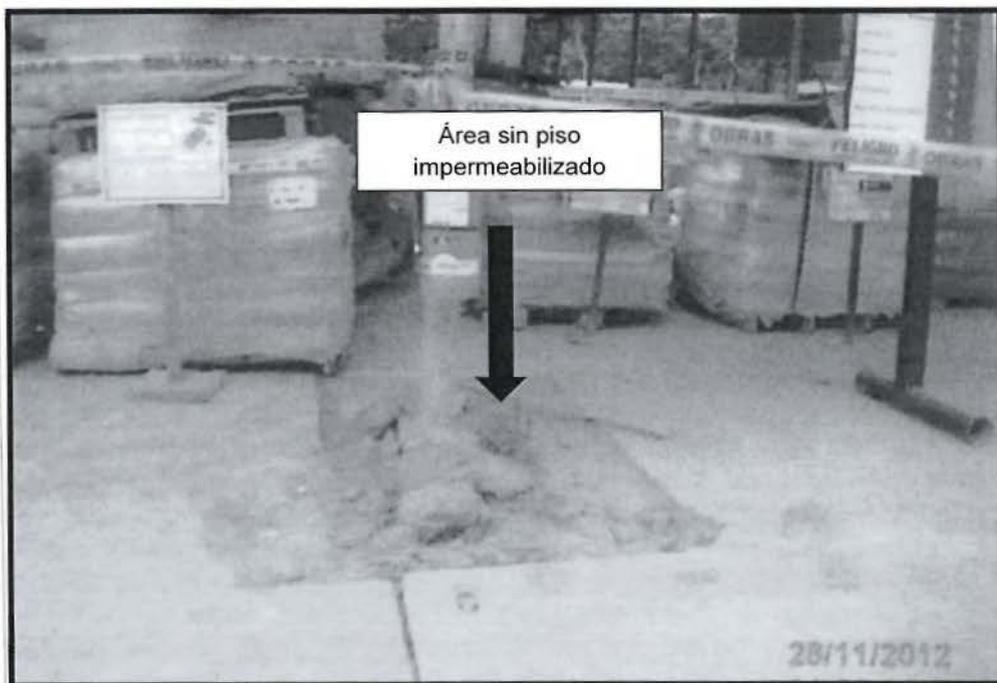
**Fotografía N° 03:** Rotura de geomembrana en la base de columna N° 2, se observa exposición del suelo, Almacén de Sustancias Químicas – Drilling.
