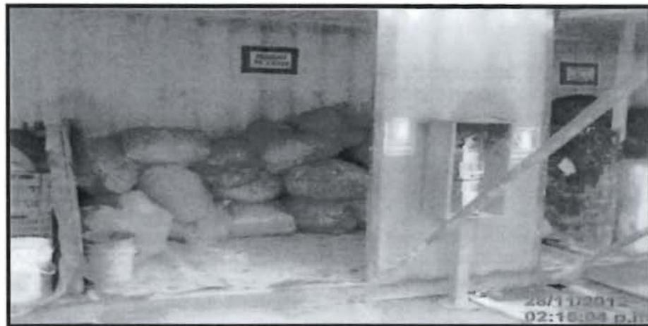
**Fotografía N° 06:** Almacén de Residuos Sólidos Peligrosos no tiene un muro de contención secundario en la parte frontal.
