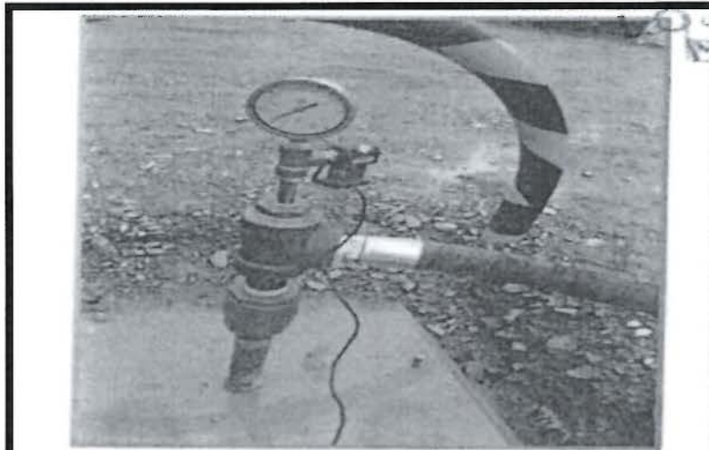
Foto N° 2: Inyección de Nitrogeno Ducto de 24"
