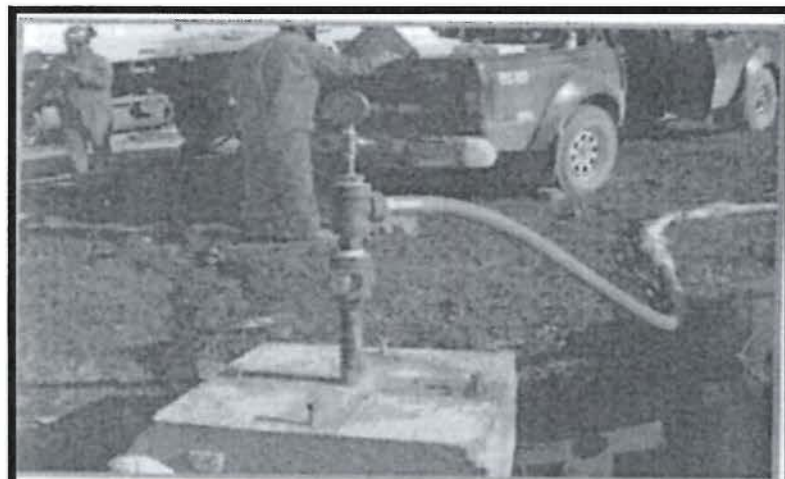
Foto N° 3: Inyección de Nitrogeno Ducto de 32"
