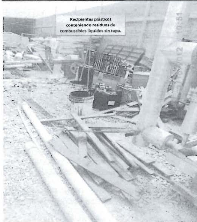
Foto 7a: En el área abierta se constató el almacenamiento de RR.SS. Peligrosos
