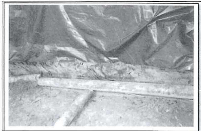
Piso con geomembrana doblado en berma para evitar posibles escurrimientos.
