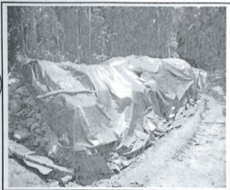
Fotografía N° 13: Muestra el acopio de residuo sólido peligroso en un área inadecuada, no cuenta con techo a dos (2) aguas; en Coordenadas: 0626681/8921368.
