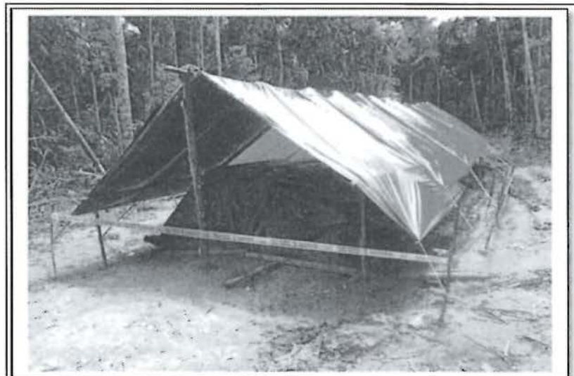
Almacenamiento de tierra impregnada de combustible techado y señalizado.
