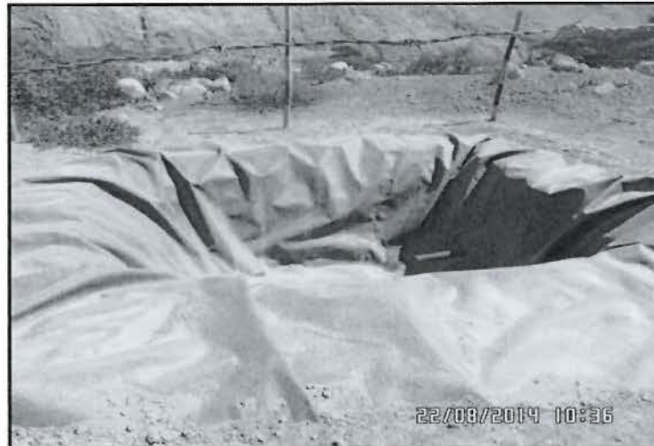
FOTO N° 4: Otra vista de la poza de recolección de lixiviados de la trinchera sanitaria, esta se encuentra vacía.
