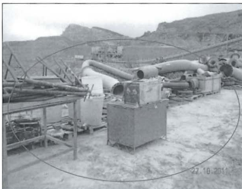
Fotografía N° 25: Disposición de residuos industriales peligrosos y no peligrosos con materiales nuevos sobre terreno natural en el Almacén de Chatarra de Mantenimiento Mecánico, Recomendación N° 9, UM Cerro Corona, 2011.
