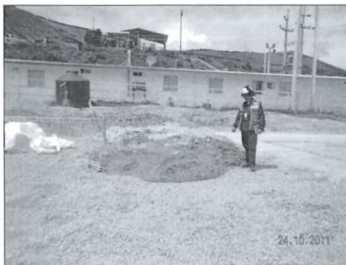
Fotografía N° 3: Lodos dispuestos fuera de la losa de impermeabilización del Taller de lavado de camiones de la zona Arpón, contaminando el suelo directamente., Recomendación N° 1 de la Unidad Minera Cerro Corona 2011
