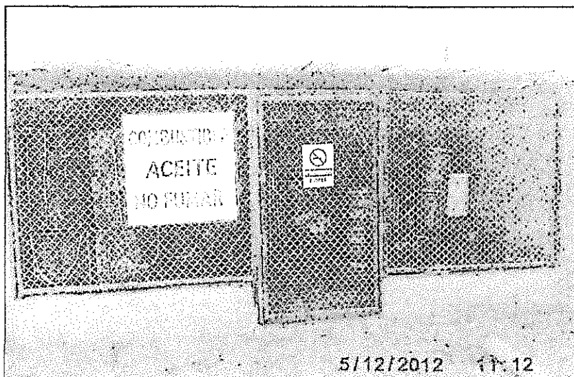
Foto N° 17. Vista del almacén de residuos peligrosos, falta rotulado e identificación del tipo de residuo.
