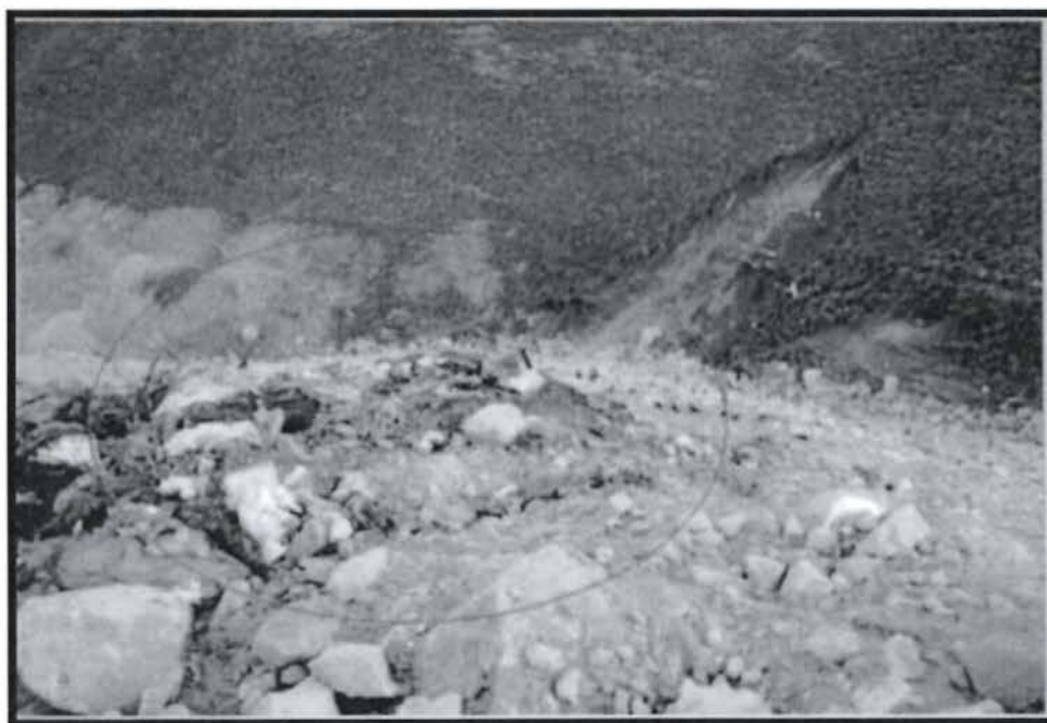
Fotografía N° 72.- Trinchera de eliminación en botadero Este (E: 273,340, N:8°942,955, Altitud: 4712 msnm), obsérvese la mala cobertura de los residuos sólidos y la proliferación de aves (vectores), UEA Antamina.
