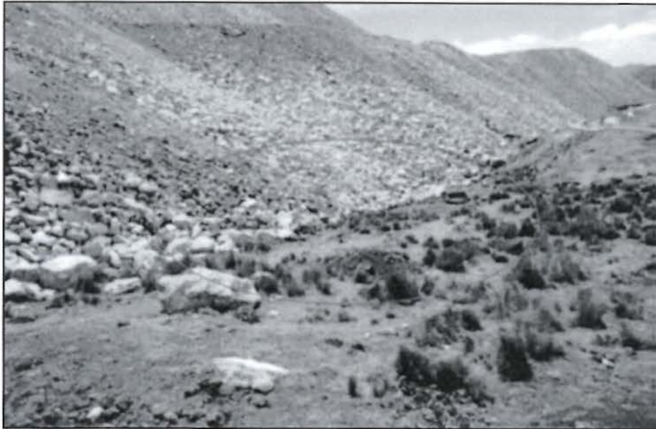
Fotografía N° 37: Depósito de desmontes Este, no se observa estructuras hidráulicas como canales de coronación. UEA Antamina.
