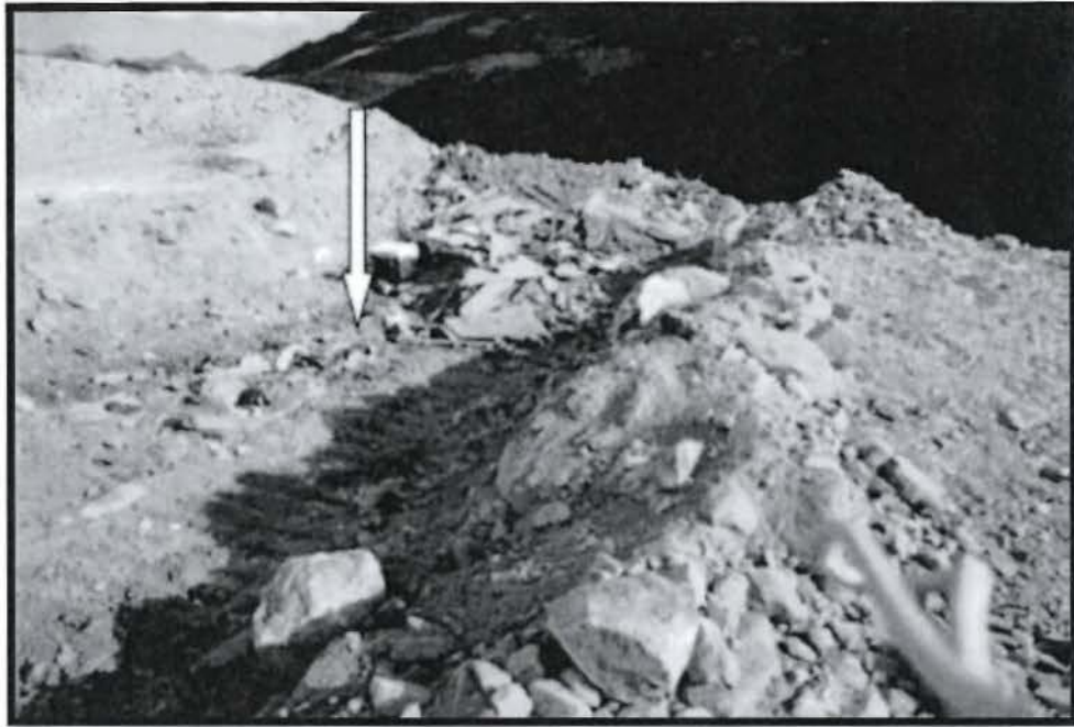
Fotografía N° 73.- Trinchera de eliminación en botadero Este (E: 273,340, N:8'942,955, Altitud: 4712 msnm), obsérvese la disposición de residuos sólidos para su tapado, UEA Antamina.
