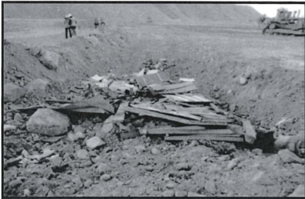
Fotografía N° 75.- Trinchera de eliminación en botadero Este (E: 273,340, N: 8°942,955, Altitud: 4712 msnm), obsérvese la disposición de residuos sólidos para su tapado, UEA Antamina.
