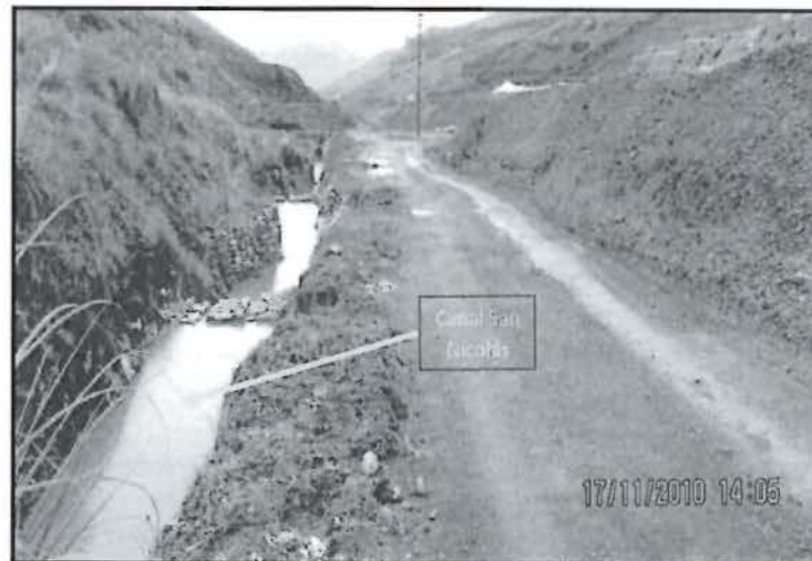
Fotografía N° 8: Continuación del canal Minera San Nicolás en suelo natural que colecta aguas de infiltración de pasivo ambiental de relavera 2.
