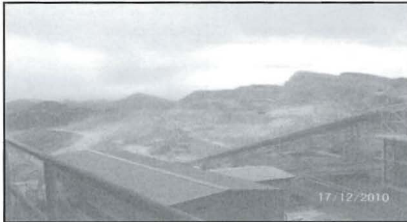
Fotografía N° 43 del Informe de Supervisión: En el acceso que va hacia el tajo Cerro Corona, se evidenció la presencia de polvo por el paso de los camiones, a pesar de que el titular realiza el regado de las vías con camiones cisterna.
