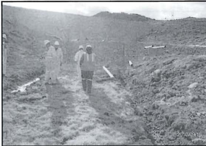
Fotografía N° 70: Proyecto Recrecimiento Relavera N° 6. Recomendaciones 3 y 4 de la Supervisión ambiental 2009.
