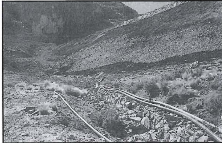
Foto N° 99: Cierre progresivo del depósito de relaves N° 5, donde se verificó que han estabilizado el talud y está en proceso de colocado de top soil.
