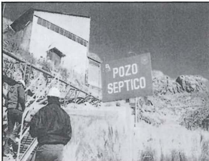
Fotografía 53: Poza séptico de zona industrial, no declarado a la autoridad competente.
