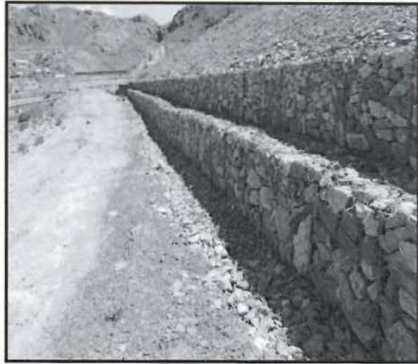
Fotografía N° 1: Gaviones en el lado sur, vista hacia oeste.
