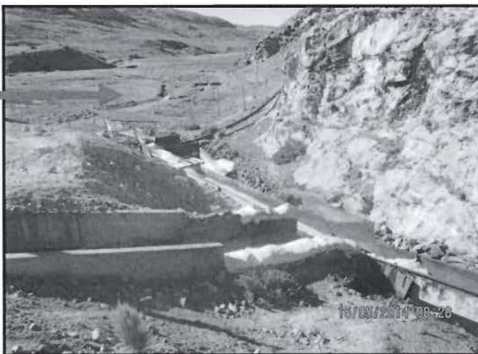
Fotografía N° 9: Canal de conducción del efluente tratado de la Poza Vetillas que descarga al río Arcopampa.
