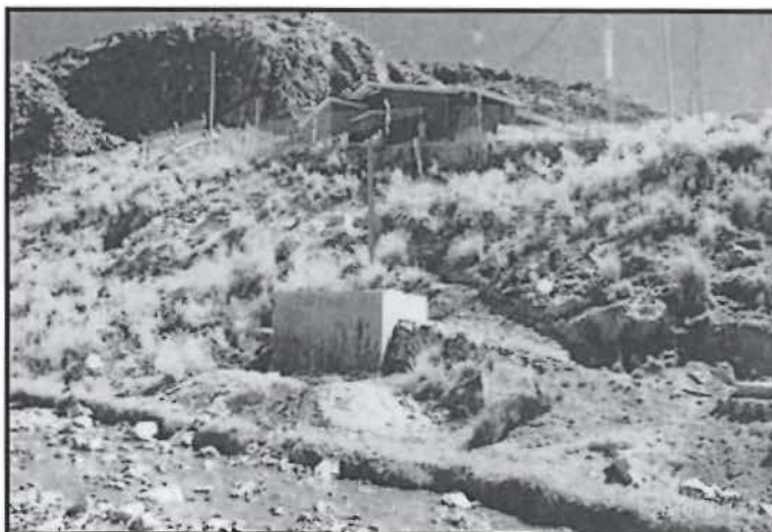
Fotografía 54: Pozo séptico de oficinas administrativas, no declarado a la autoridad competente.
