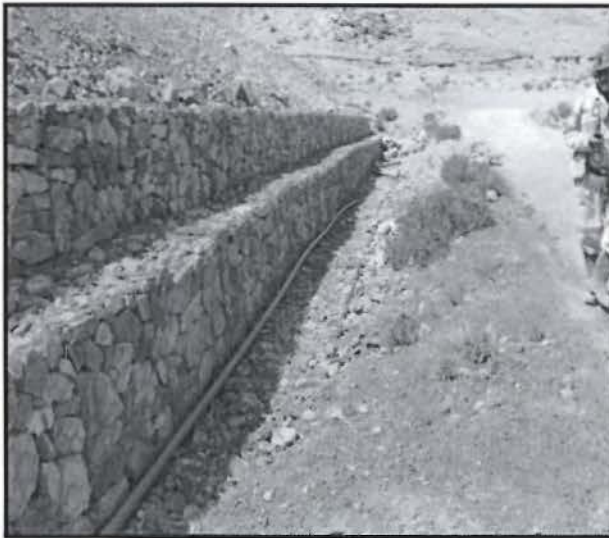
Fotografía N° 2: Gaviones en el lado sur, vista hacia este.
