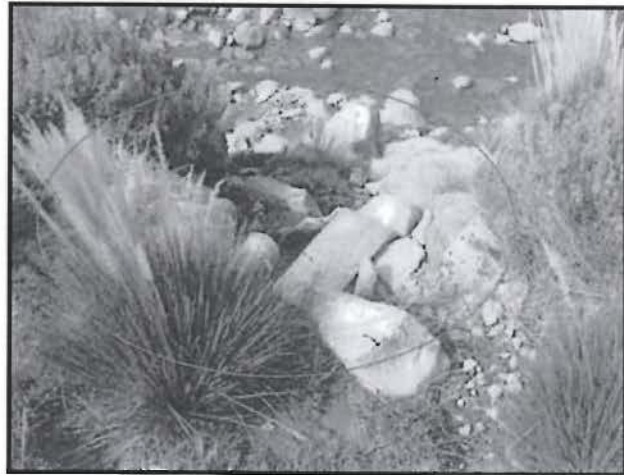
Fotografía 118: Descarga de efluente del pozo séptico de la planta concentradora hacia el cauce del río Arocampa, U.P. Arcata, viene fotografía N° 117. Recomendación N° 13.
