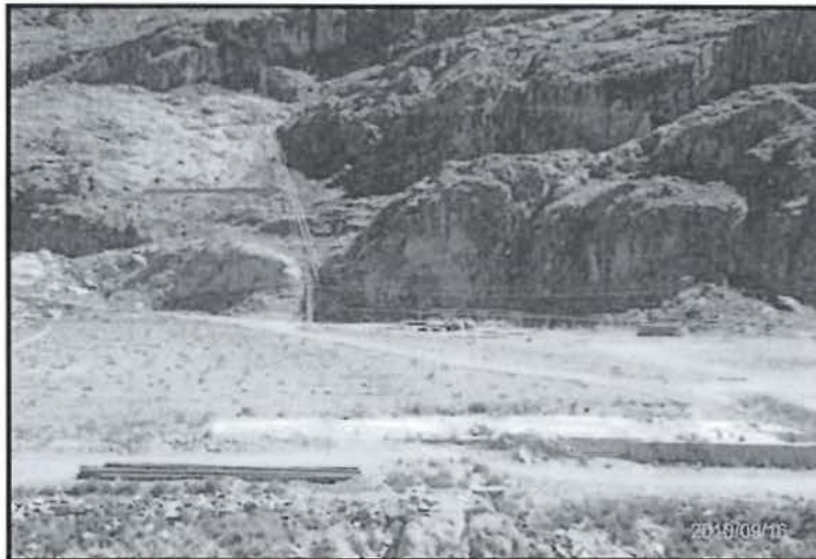
Fotografía N° 18: Conducción de relaves Planta Concentradora hacia Relavera N° 6. Recomendación N° 5 de Supervisión Ambiental 2009, levantada en 80% (instalación de sensores que detienen el bombeo): la empresa minera debe implementar el sistema de contención de contingencias (derrames) que evite impactar el medio natural.
