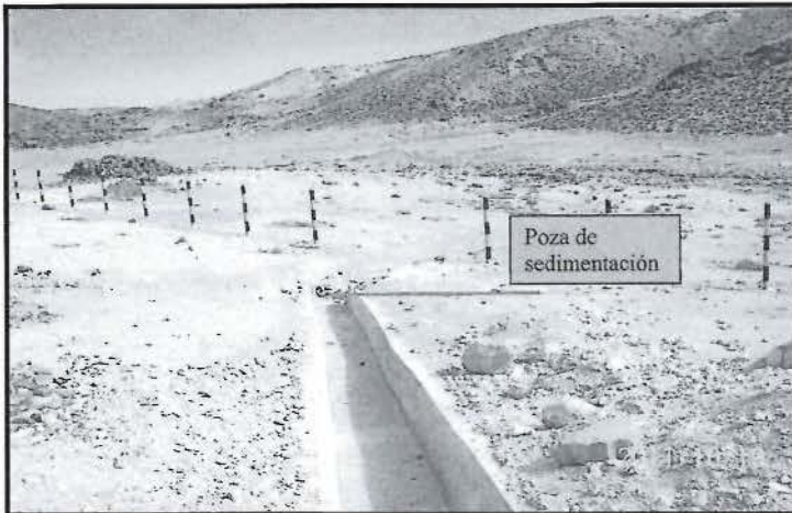
Foto N° 44: Canal de concreto donde descarga las aguas de lluvia a una poza de sedimentación por gravedad y el rebose va a la quebrada Tacacocha.
