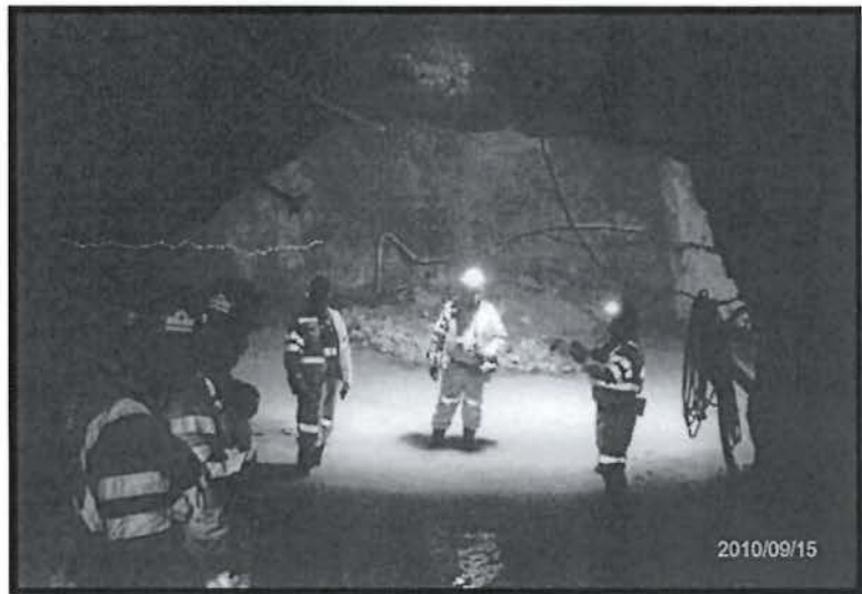
Fotografía N° 6: Mina – Manejo de aguas. Recomendación N° 2 de la Supervisión Ambiental 2009, levantada en 60%. Vista de futura Sala de Bombas.
