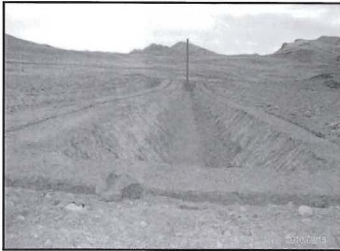
Fotografía N° 34: Relleno sanitario en construcción. Recomendación N° 10 de Supervisión ambiental 2009, levantada en 80%.
