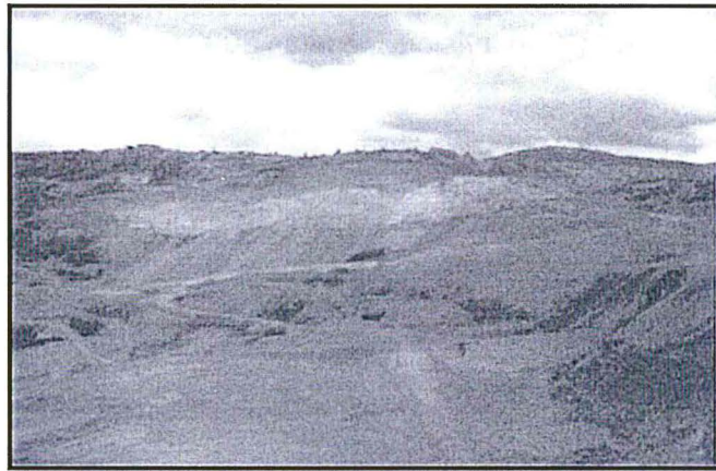
Fotografía N° 10: Vista panorámica del Tajo Clarita Oeste que muestra actividades de explotación, las mismas que no cuentan con la documentación que autoriza su operación.
