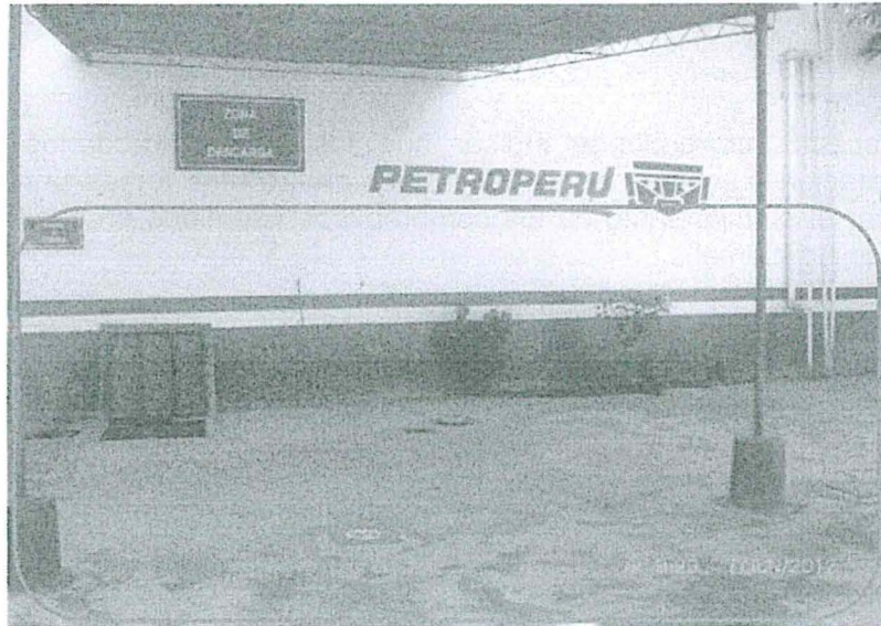
Fotografía N° 4: Área de tanques
