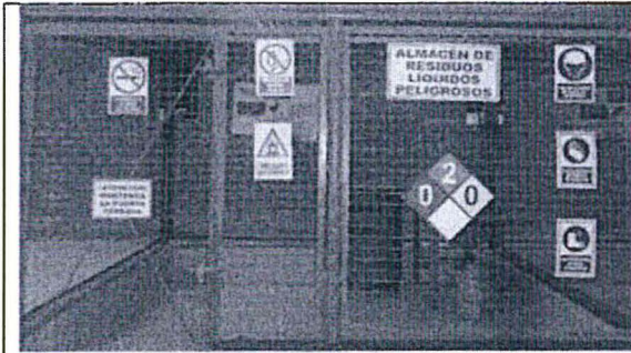
Foto 1 Señalización del Almacén con Residuos Líquidos
