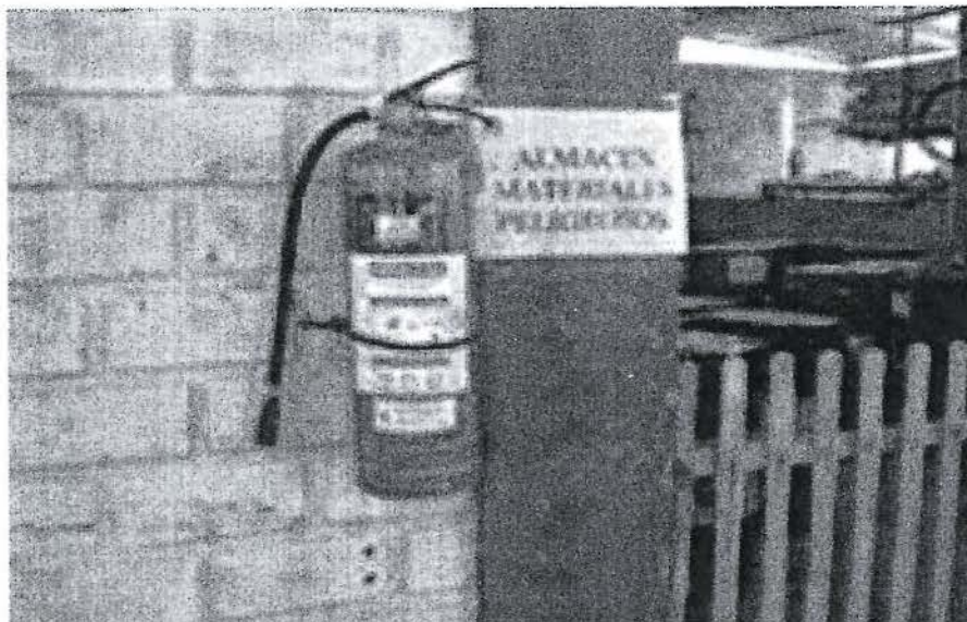
Vista del área donde Electro Oriente almacena los residuos sólidos en la CT Bellavista, el cual cuenta con sistema contra incendios.
