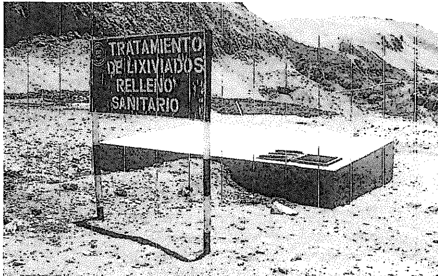
Fotografía N° 63: Sistema de tratamiento de lixiviados del relleno sanitario.
