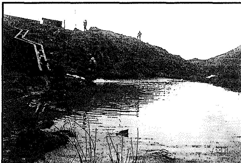
Fotografía N° 54 de la Supervisión Regular 2011: No se observa la poza de contingencia
