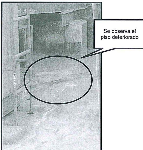
Foto 30: Obs. 8 (2009): Piso del sumidero del deslaminado y Torres de enfriamiento de la Casa de Celdas deteriorado.
