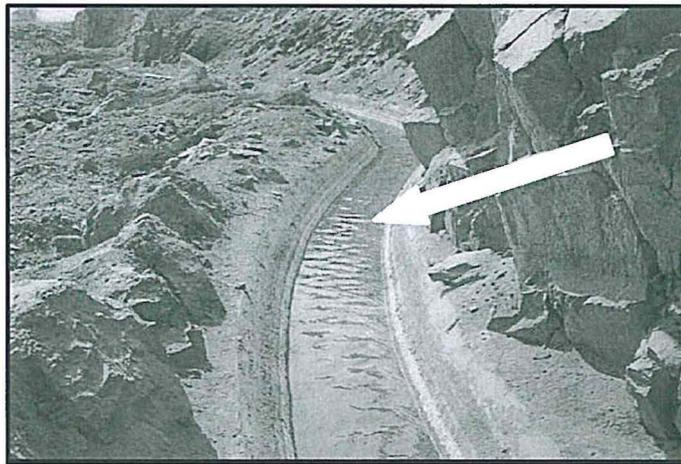
Fotografía 19 del Informe de Supervisión: Canal de regantes que se tiene alrededor de las instalaciones, aun expuesto a la incorporación de material particulado.
