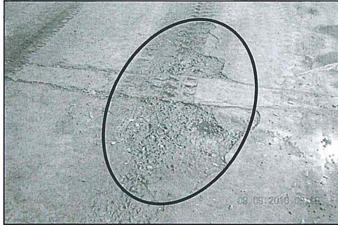
Fotografía 11 del Informe de Supervisión: Piso del sumidero del deslaminado y Torres de enfriamiento de la Casa de Celdas deteriorado.
