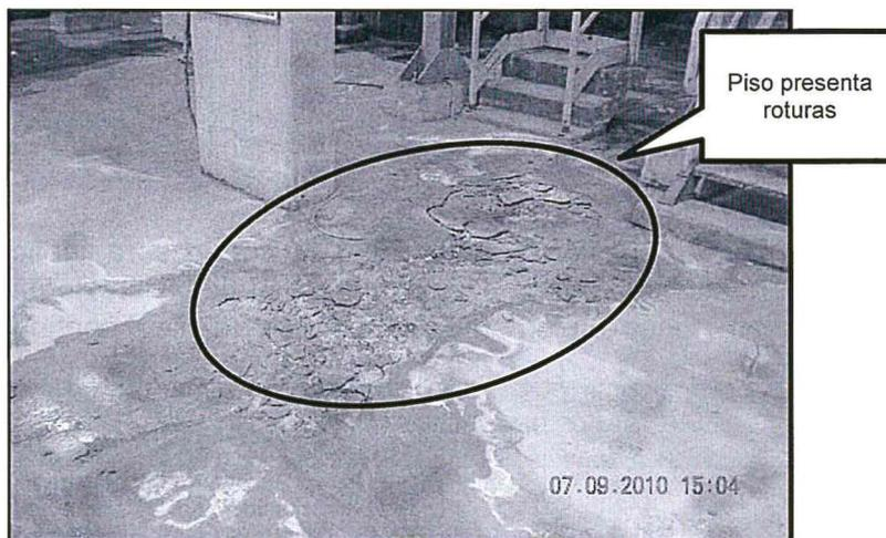
Fotografía 10 del Informe de Supervisión: Piso de la poza de contención del tanque espesador D039 de Lixiviación no ha sido reparado.
