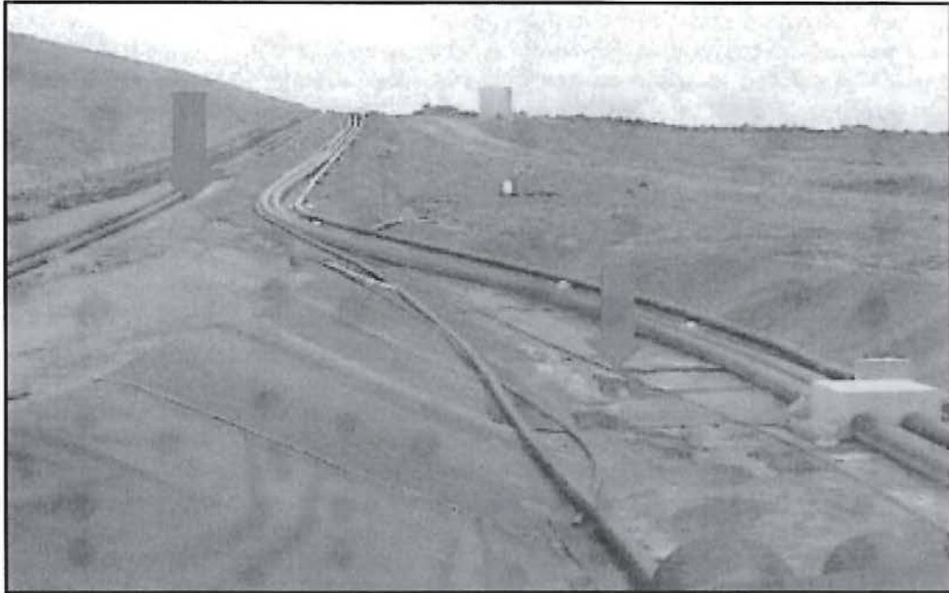
Fotografía N° 153. Cumplimiento de recomendación N° 4-2011: Vista del canal impermeabilizado con geomembrana con las tuberías de conducción de HDPE sin sedimentos.
