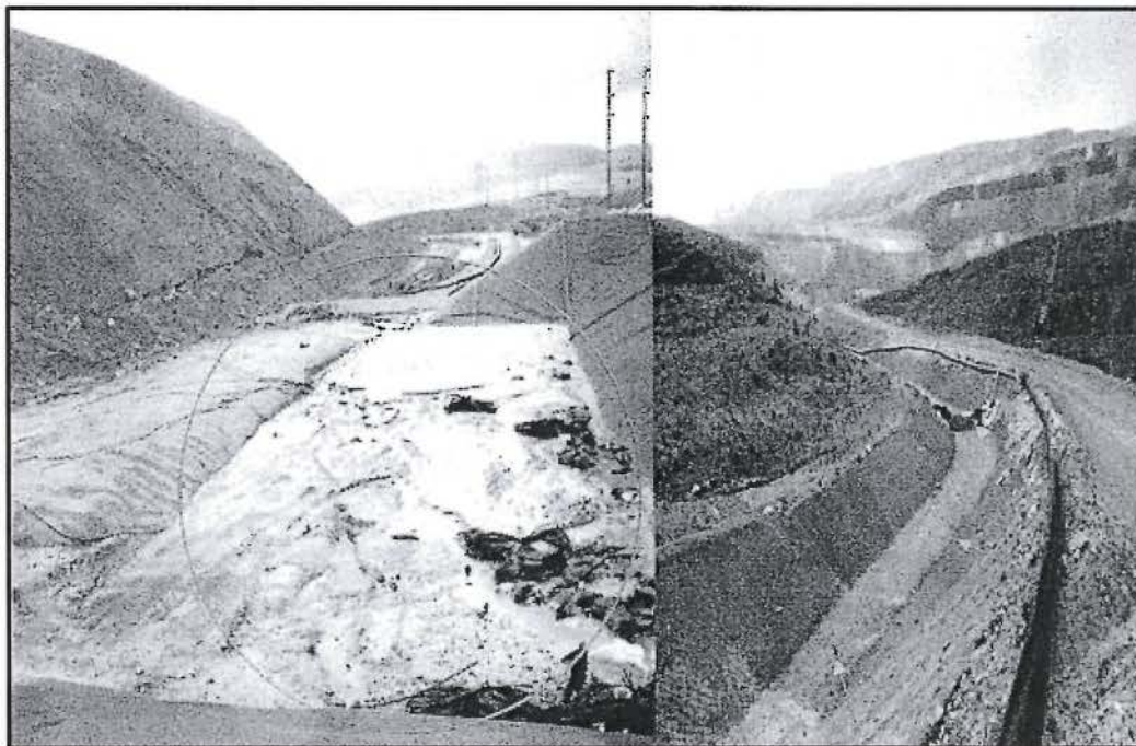
Fotografía N° 15.- Observación 4, supervisión 2011: Se puede observar la presencia de sedimentos sobre el canal (revestidos con geomembrana) donde conducen las tuberías de HDPE, ubicado en el Pad de Lixiviación Yanacocha Norte.
