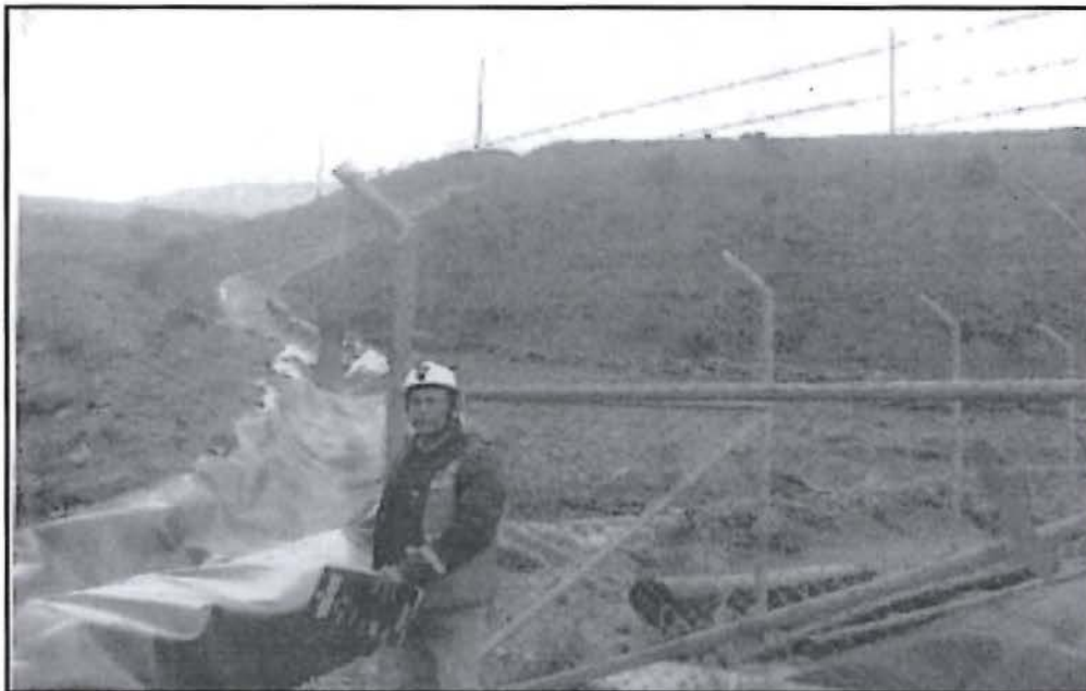
Fotografía N° 150. Cumplimiento de recomendación N° 2-2011: Verificación por el supervisor Carlos Cenzano del canal recubierto con geomembrana cerca a la poza SUMP N° 5 (flecha).
