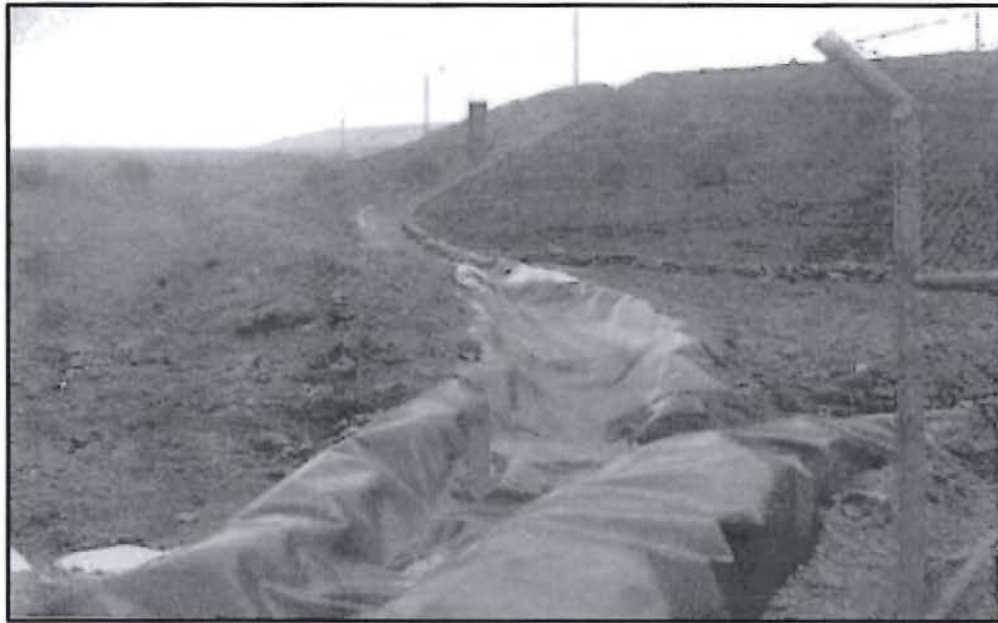
Fotografía N° 149. Cumplimiento de recomendación N° 2-2011: El recubrimiento del canal de drenaje cerca a la poza SUMP N° 5 ha sido completado con geomembrana asegurando su protección contra la erosión pluvial.
