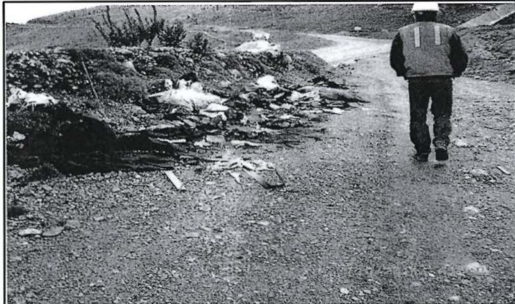
Fotografía N° 20.- Observación 7, supervisión 2011: En la carretera de acceso a la estación de monitoreo de geotécnica de los piezómetros de cuerda vibrante LQVP 06-06, LQVP 06-08, LQVP 06-09, instalado en el depósito de Desmonte La Quinua, se observó material de desecho disperso, faltando una disposición adecuada de los residuos sólidos industriales.
