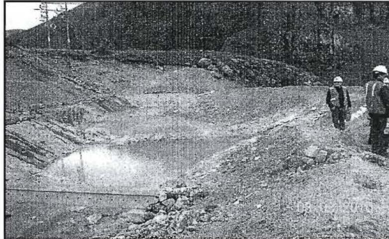
Foto N° 03. Canal de derivación La Quinua antes de ingreso a la Quebrada Encajón con restos del agua ácida del derrame.
