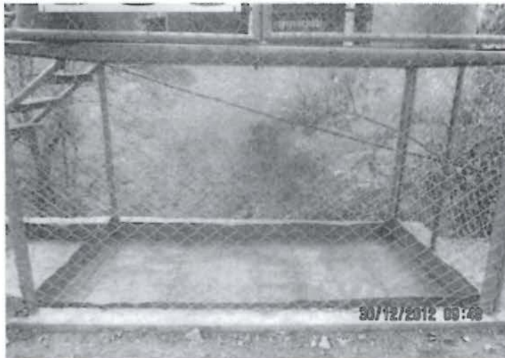
Fotografía N° 3.2 implementación de bandeja de mayor tamaño para contener aceites y Grasa Residuales
