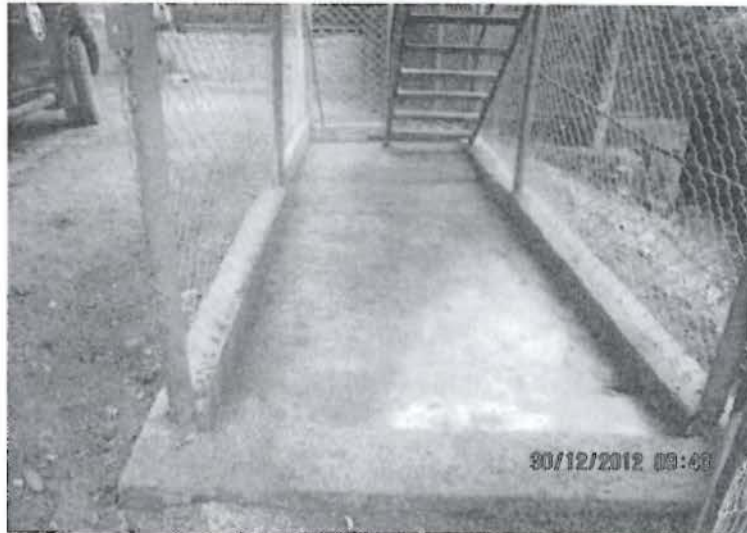
Fotografía N° 3.3 Vaciado de concreto para impermeabilizar el suelo
