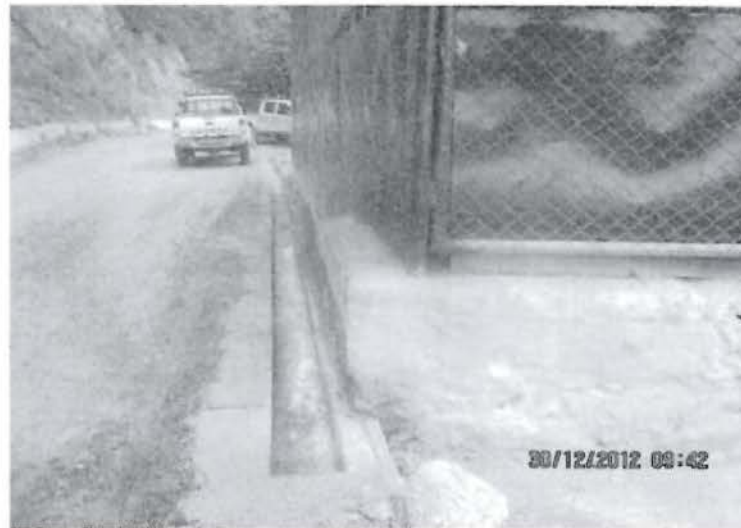
Fotografía N° 3.4 Construcción de canaleta de drenaje cubre todo el taller
