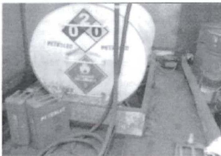
**Vista 26.** El tanque diésel no cuenta con un adecuado sistema de contención que evite posibles derrames de hidrocarburos.
