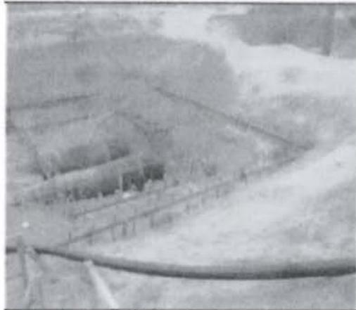
**Vista 12.** Sistema de desaguado hacia el mar de las excavaciones en el terreno de la CT Chilca.
