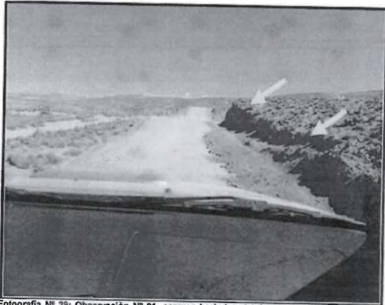
Fotografía N° 29: Observación N° 01, accesos hacia las plataformas Canahuire (quebrada Agani), con las respectivas cunetas de para derivar aguas de escorrentía.
