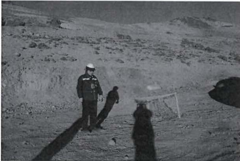
Fotografía N° 24 . Se observa que las plataformas construidas no cuentan con canal de coronación de manejo de escorrentías superficiales en la zona de Canahuire en la quebrada Agani.
