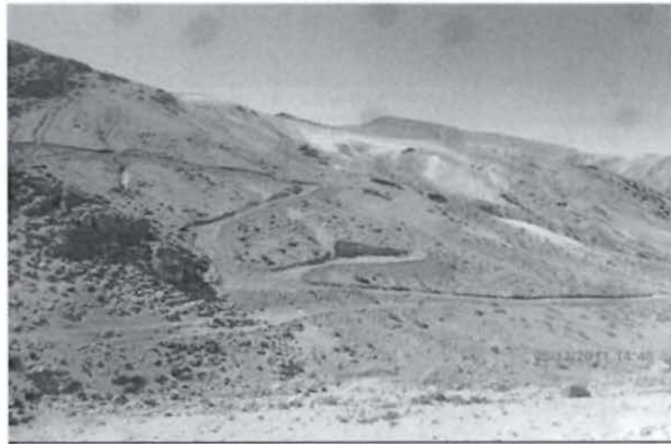
Foto 22: Recomendación 03-2010, vías de acceso al área de exploración Katrina, sin cunetas construidas.
