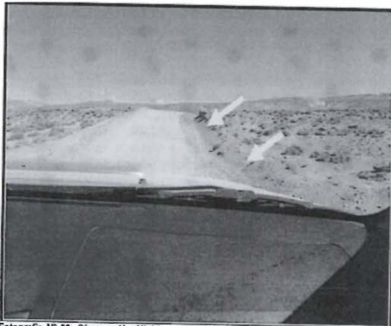
Fotografía N° 30: Observación N° 01, accesos hacia las plataformas Canahuire (quebrada Agani), con las respectivas cunetas de para derivar aguas de escorrentía.
