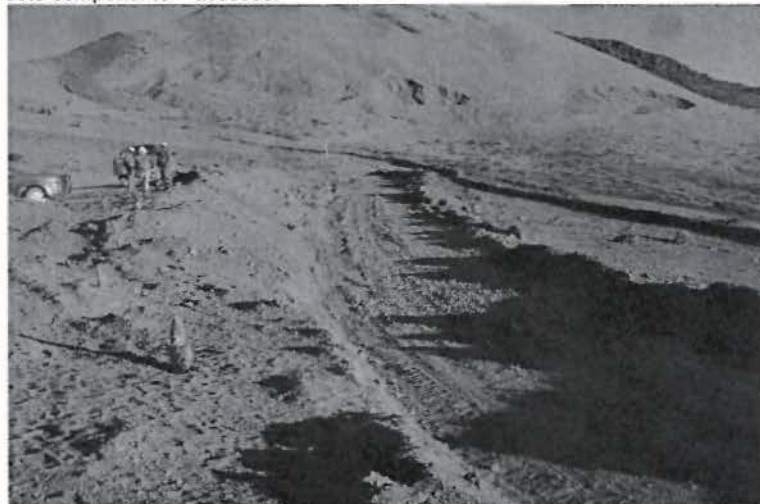
Fotografía N° 29 . Otra vista en el área del proyecto Chucapaca en la que se observa que las vías de acceso a las áreas de plataformas de exploración en el área de Katrina no cuentan con cunetas proyectadas para este componente – accesos.
