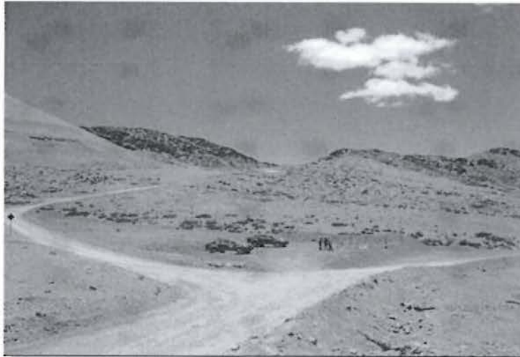
Foto 20: Recomendación 01-2010, plataforma y poza de lodos del área de exploración Canahuire, quebrada Agani, sin canales de coronación y accesos sin cunetas.
