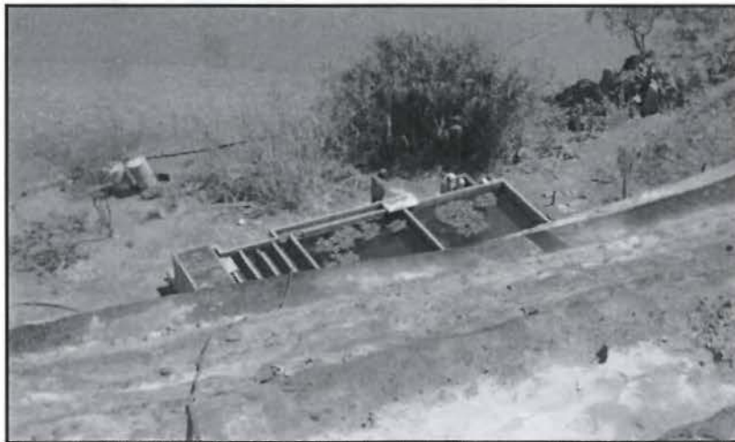
Fotografía N° 51 Vista del sistema de tratamiento del agua debajo de la cancha de relaves
