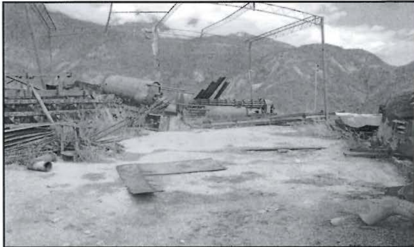
Fotografía N° 42: Vista del depósito de materiales reutilizables y chatarras ubicado próximo a la cancha de relaves.
