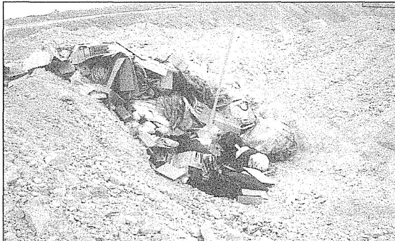
Fotografía N° 15 del Informe de Supervisión: Botadero de residuos sólidos domésticos donde se observan cartones, filtros de aire, bolsas de plástico, etc., que se encuentran sin recubrimiento con material de préstamo, y tampoco cuentan con señalización y letreros de información.
