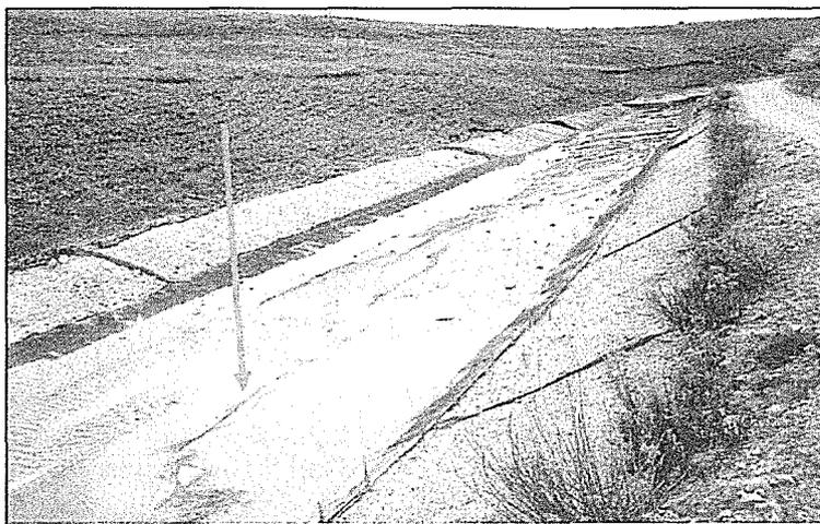
Fotografía N° 3 del Informe de Supervisión: Canal de coronación (lado Este) para las aguas de escorrentías del Pad y Pozas de Proceso del Tajo Maqui Maqui, que en su interior se encuentran sedimentos.
