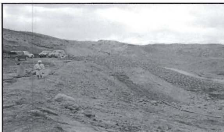
Fotografía N° 2 del Informe de Supervisión: Se observa la Poza N° 01, de aproximadamente 6x5x2 m., como contención de la Bocamina Yuraccmachay Nv 560 - BMY-1.
