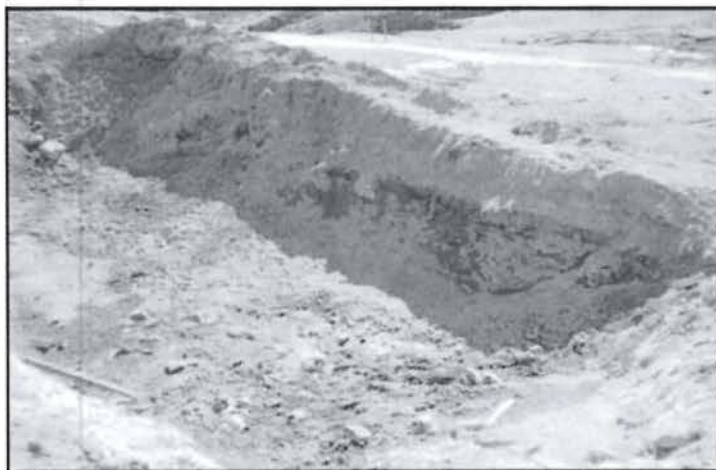
Fotografía N° 15 del Informe de Supervisión: La Poza N° 01 se encuentra sin agua, al ser evacuada por cisternas a la planta de tratamiento de aguas de mina.
