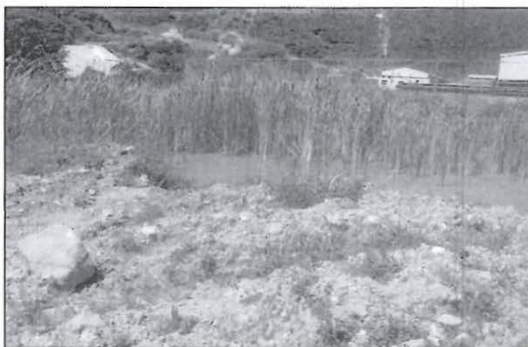
Fotografía N° 34: Poza N° 4, almacenamiento de lodos de la PTAAA, se observa crecimiento de vegetación. Observación N° 1
