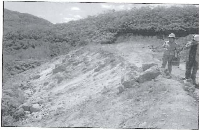
Fotografía N° 30: Botadero N° 3: desmontes de desbroce de taludes de plataformas, accesos y otros, no cuenta con canales perimetrales de aguas de escorrentía. Observación N° 2.
