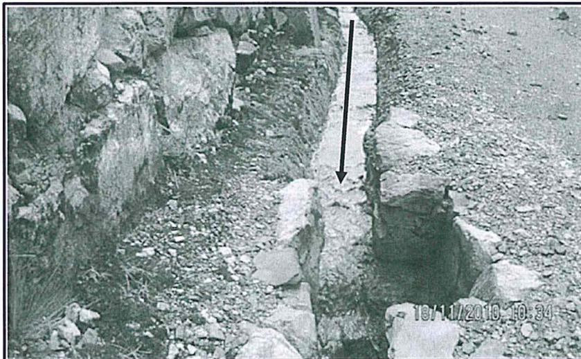
Fotografía N° 3 del Informe de Supervisión.- Canal construido en el suelo natural que colecta las aguas ácidas de las desmonteras en la parte superior del tajo "El Zorro"
