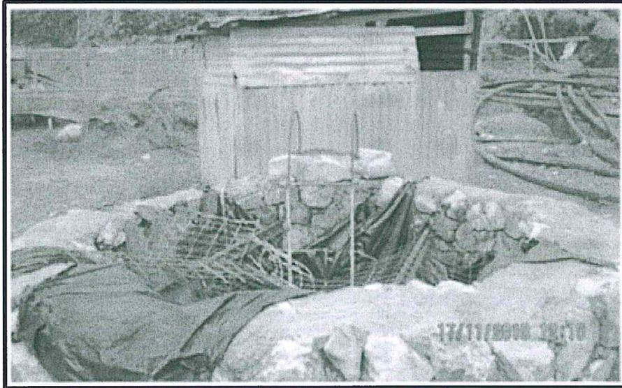
Fotografía N° 23 del Informe de Supervisión.- Boca del pozo N° 2 de control de aguas subterráneas construido con mampostería enrocado y escalera para acceso de personal y bomba de impulsión de las filtraciones hacia la poza de solución rica. Existen filtraciones de solución cianurada.
