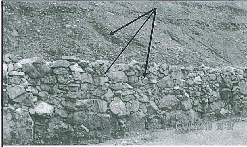
Fotografía N° 14 del Informe de Supervisión.- Pasivo de desmontera "PAMA 2" que infiltra agua de lluvias con potencial de lixiviación de minerales.
