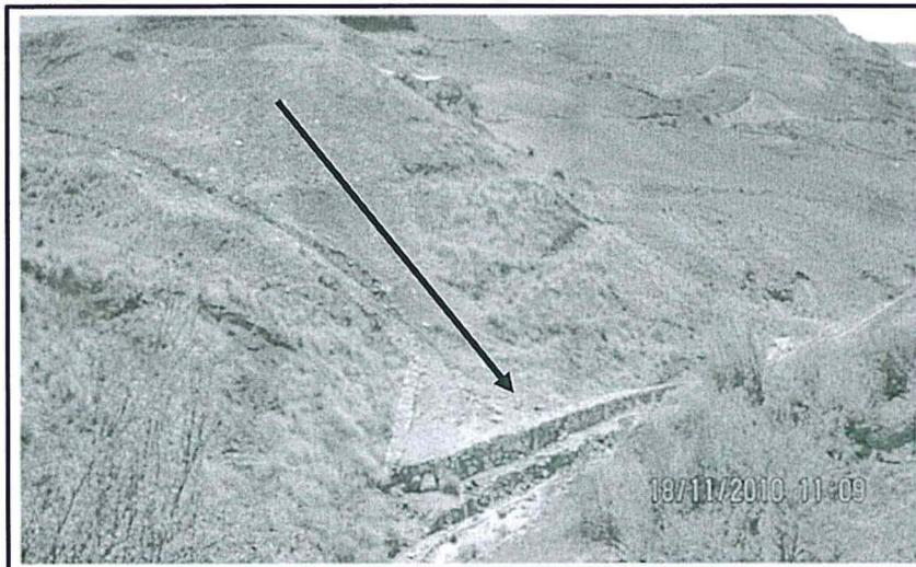
Fotografía N° 11 del Informe de Supervisión.- Desmontera en la parte superior del tajo "El Zorro" con evidencia de erosiones por aguas de lluvias y arrastre de sedimentos hacia el río Tingo que cruza en la parte inferior.
