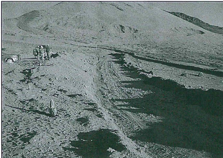
Fotografía N° 29 del Informe de Supervisión.- Otra vista en el área del proyecto Chucapaca en la que se observa que las vías de acceso a las áreas de plataformas de exploración en el área de Katrina no cuentan con cunetas proyectadas para este componente – accesos.
