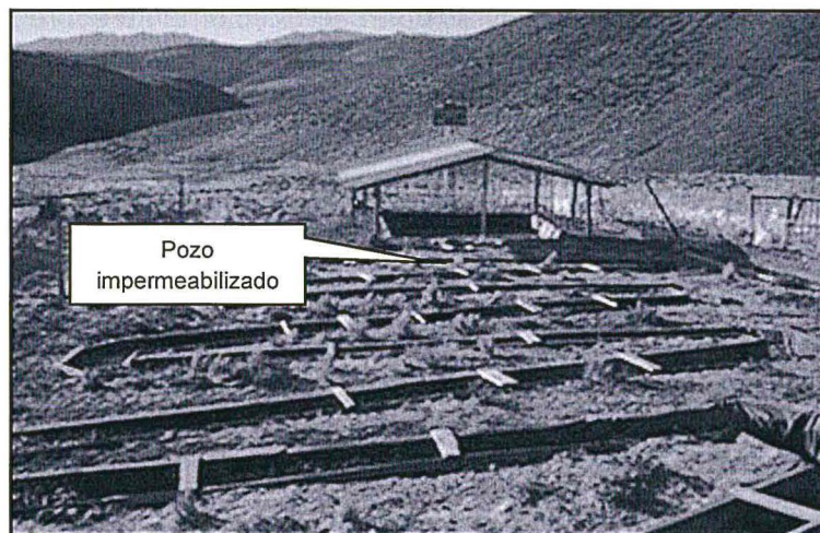
Fotografía N° 30 del Informe de Supervisión.- El sistema de tratamiento de aguas servidas presenta remanente que se almacena en pozo impermeabilizado, es distinto al establecido en el EIAsd aprobado.
