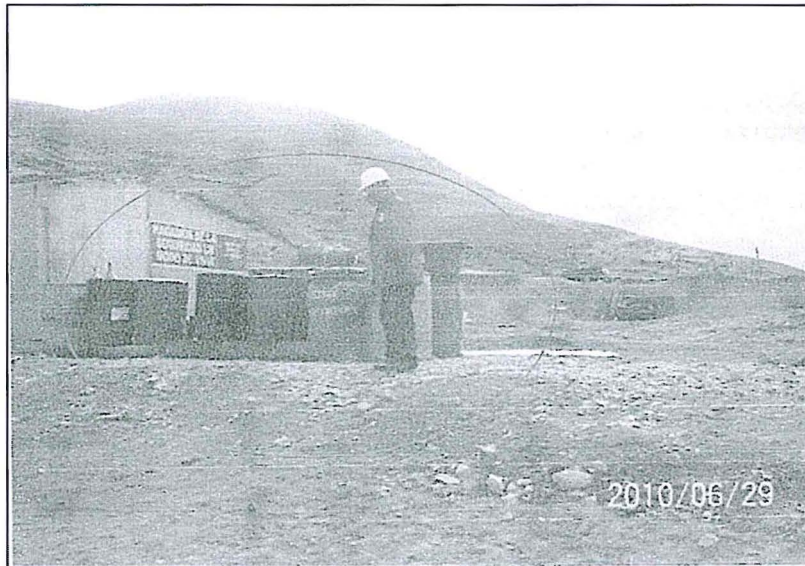
Fotografía N° 56 del Informe de Supervisión: Almacén temporal de hidrocarburos y residuos sólidos industriales, se observa que no cuenta con la protección perimetral y la cobertura correspondiente.
