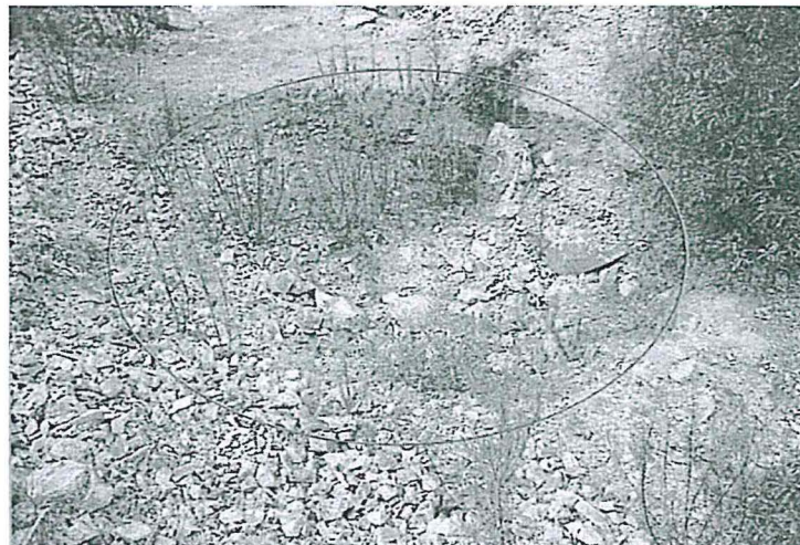
Fotografía N° 34 del Informe de Supervisión: Poza de lodo en plataformas construida no se ha tapado y nivelado adecuadamente.
