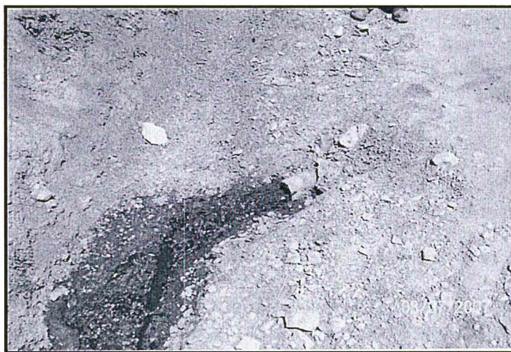
Fotografía N° 14: Se ha detectado un efluente doméstico e industrial que no son controlados.
