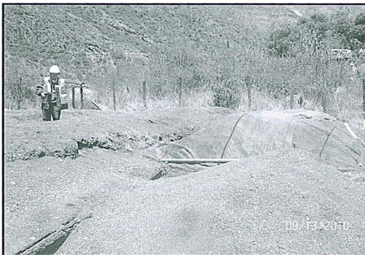
Fotografía N° 2.31 del Informe de Supervisión: En la Planta de Compostaje, los residuos orgánicos se encontraban tapados con material de cobertura, y en la otra zanja se pudo apreciar que se encontraba cubierto con material de geotextil.
