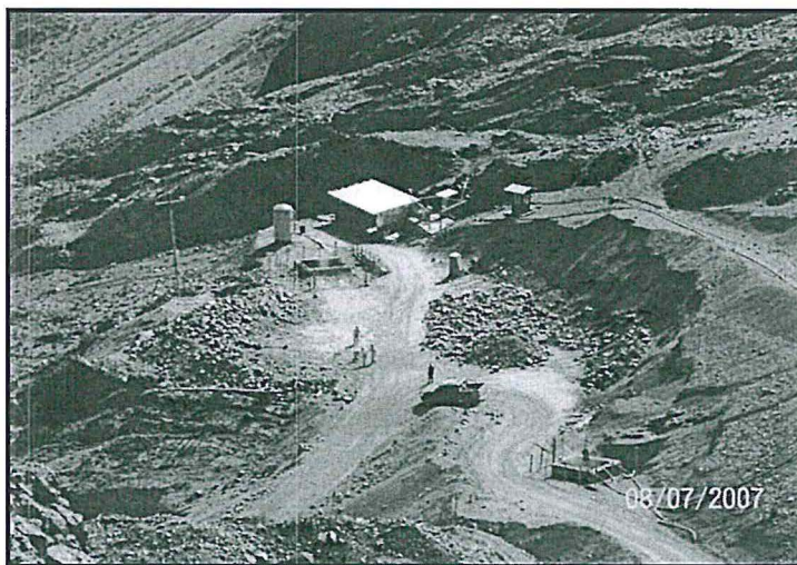
Fotografía N° 12: En el sector Berlín se vienen utilizando áreas como canchas temporales de mineral, sin una preparación adecuada de las mismas.
