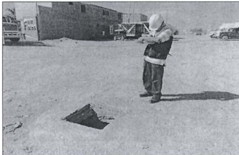
Foto N° 4.- Buzón colector en la parte externa el EIP SEAFROST S.A.C.
