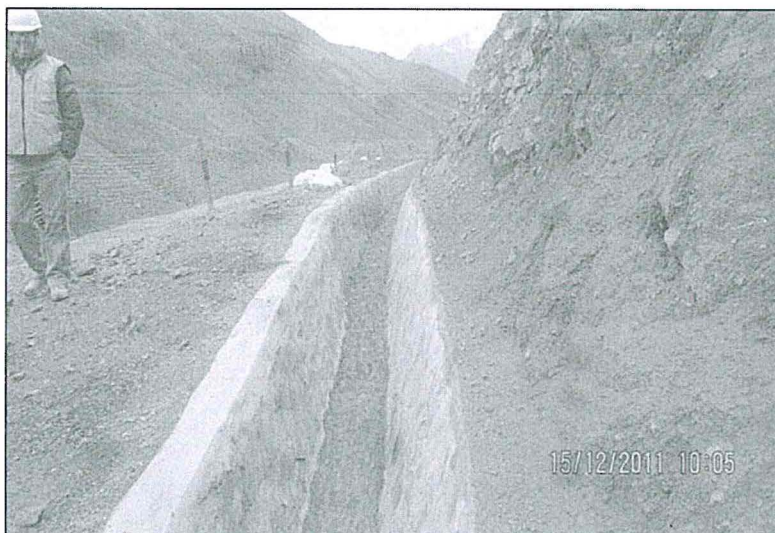
Fotografía N° 50 del Informe de Supervisión: Canal de coronación del depósito de relaves Chinchán
