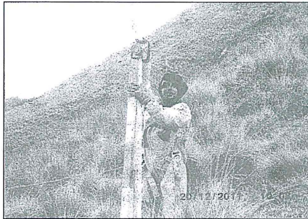
Instalación del hito topográfico en la cresta superior del talud
