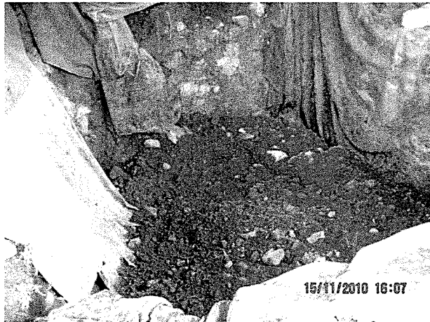
FOTOGRAFÍA N° 22.- Recomendación N° 14: Vista fotográfica de la trinchera para la disposición de los residuos sólidos domésticos, ubicado con coordenadas UTM 8936062N, 278284E y 4557 msnm., y con dimensiones de 2,60 m x 3,10 m x 2,0 m.; este se encuentra recientemente operativo.
