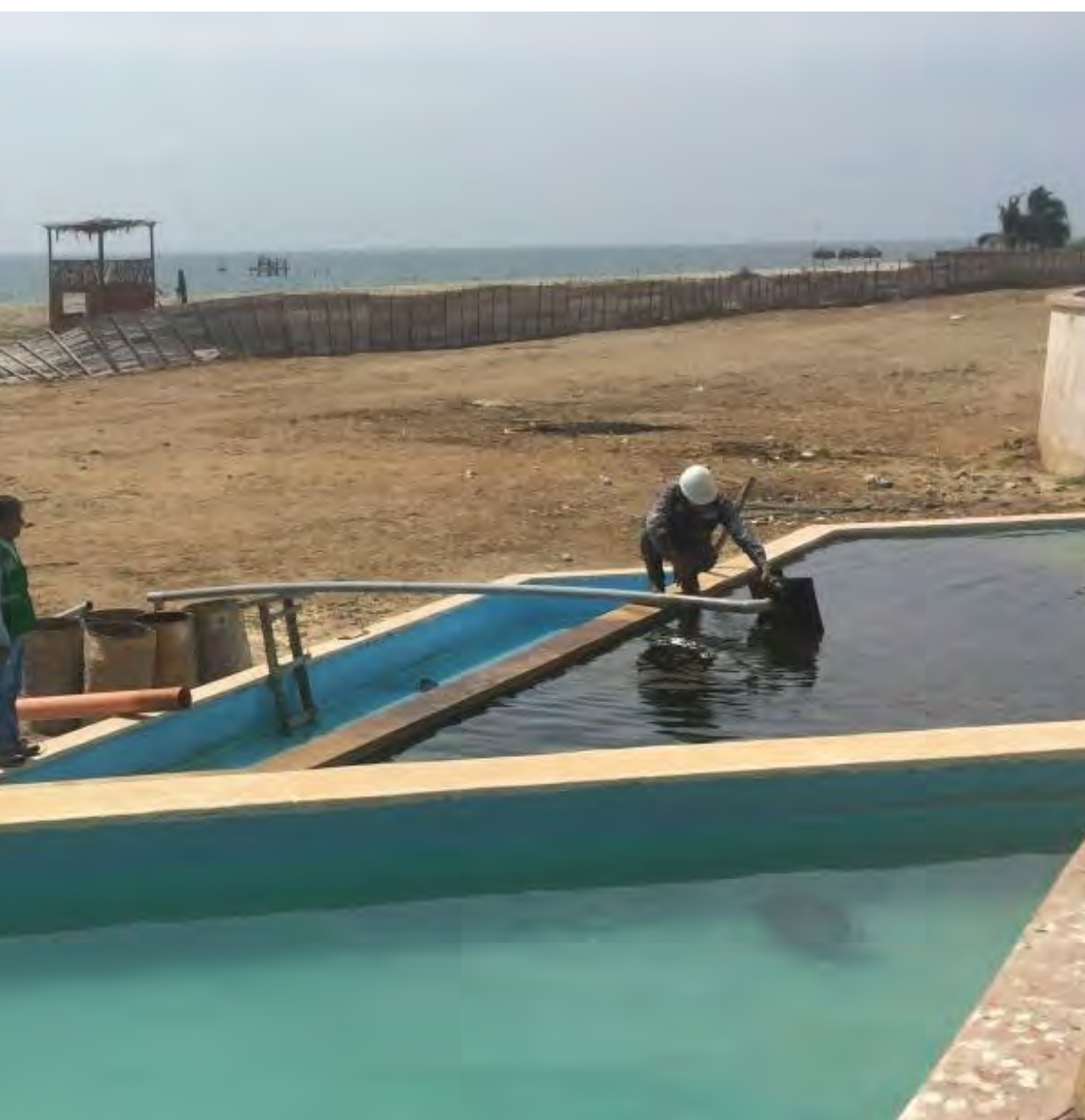
derrame ocurrido en una pileta de agua.
