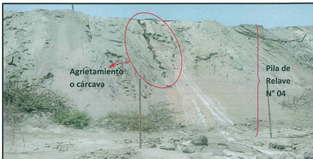
Gráfico N° 5 Cárcavas en el talud de la Pila de Relave N° 4
