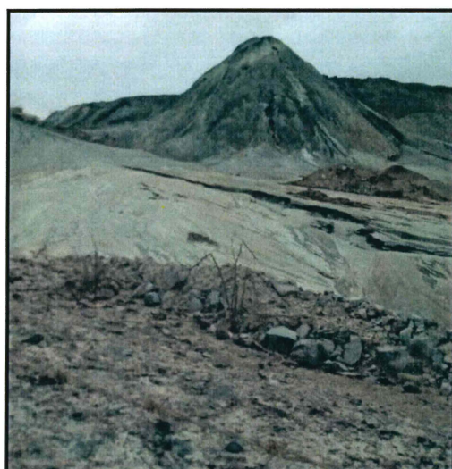
Figura N° 7 Deslizamiento de relave
