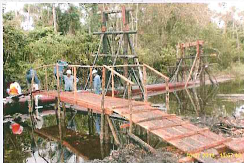
FOTO N° 8: N 9474535, E 467992 / Sistema de Poleas y Tecles implementado para levantar la tubería.
