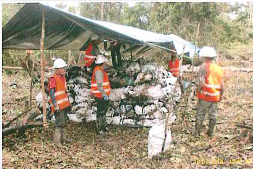
FOTO N° 10: N9474572, E 467995 / Almacén temporal de residuos Sólidos Peligrosos ubicado en el Campamento de Trabajos de Remediación, ubicado al costado de la tubería que tuvo la fuga de Petróleo Crudo.
