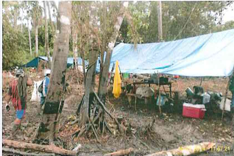
FOTO N° 5 N 9474551, E 467980 / Campamento de Trabajos de Remediación, ubicado al margen izquierdo del Canal de Flotación, al costado de la tubería, en donde se encuentra la rajadura por la que se tuvo la fuga de Petróleo Crudo
