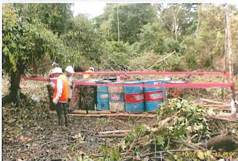
FOTO N° 11: N9474559, E 468000 / Almacén temporal de Cilindros con petróleo recuperado, ubicado en el Campamento de Trabajos de Remediación, ubicado al costado de la tubería que tuvo la fuga de Petróleo Crudo.
