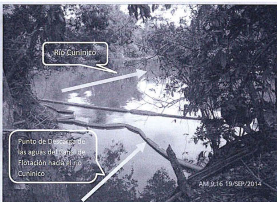
FOTO N° 23: Se observa las barreras de contención instalados a la salida del canal de descarga que conecta el Canal de Flotación con el río Cuninico. Este canal de descarga tiene características naturales propias de una Quebrada y que permanentemente descarga las aguas del canal de flotación al río Cuninico.
